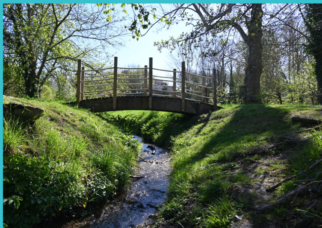
Pont du parc Albert 1 er
