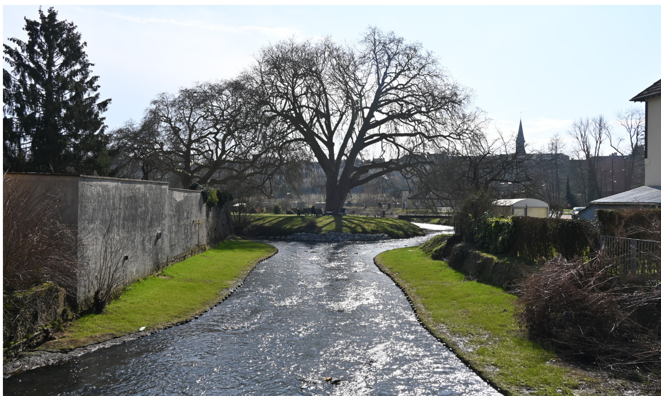
Après les travaux
