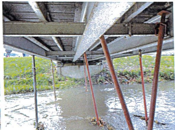
La charge admissible d'un IPE de 330 mm pour une portée de 10 m est de 8,635 To (cf abaque ci-dessous). L'ensemble étant lié, la charge admissible répartie est donc bien supérieure à 8to.
